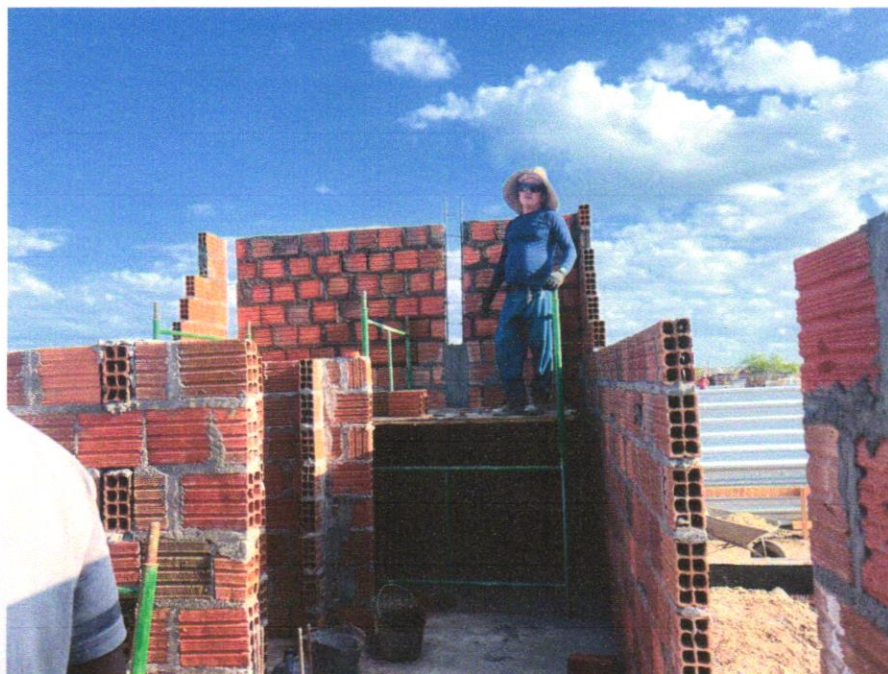
IMAGEM 09 - ALVENARIA DE VEDAÇÃO DE BLOCOS CERÂMICOS FURADOS NA HORIZONTAL DE 9X19X19 CM (ESPESSURA 9 CM) E ARGAMASSA DE ASSENTAMENTO COM PREPARO MANUAL. AF_12/2021
