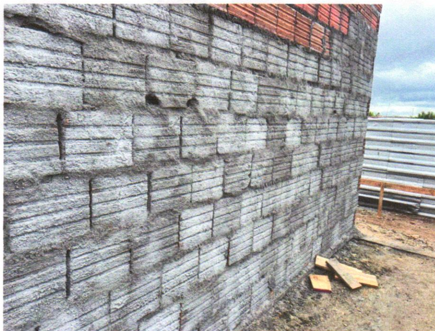
IMAGEM 10 - ALVENARIA DE VEDAÇÃO DE BLOCOS CERÂMICOS FURADOS NA HORIZONTAL DE 9X19X19 CM (ESPESSURA 9 CM) E ARGAMASSA DE ASSENTAMENTO COM PREPARO MANUAL. AF_12/2021
