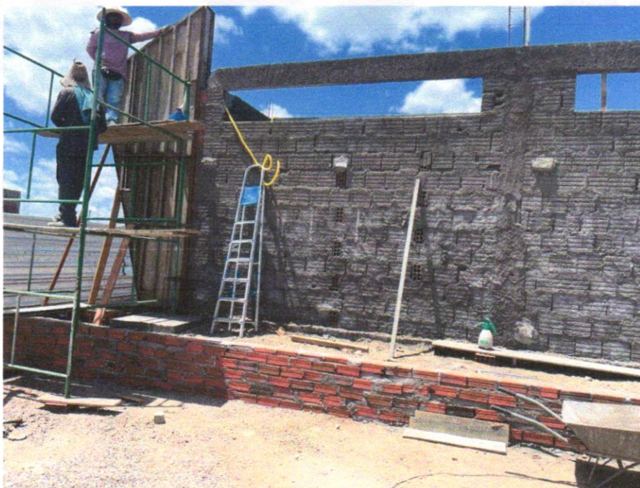
IMAGEM 12 – CHAPISCO APLICADO EM ALVENARIA (COM PRESENÇA DE VÃOS) E ESTRUTURAS DE CONCRETO DE FACHADA, COM COLHER DE PEDREIRO. ARGAMASSA TRAÇO 1:3 COM PREPARO EM BETONEIRA 400L. AF_06/2014
